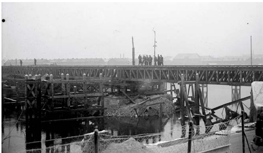
Door geallieerde pioniers gelegde spoorbrug over de rivier. Op de achtergrond links de Vogelwijk, rechts daarvan de Citadel kazerne. 30 december 1944. Foto: Erfgoed 0024012.
